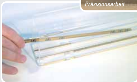
Einsetzen der Rollenträgerleiste
